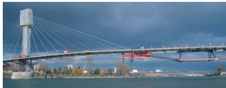
Einhebung des Mittelstückes vom Ponton mittels Litzenhebern © Leonhardt, Andrä und Partner
