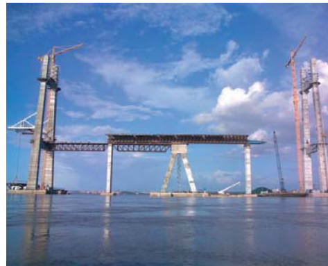
Überbaumontage Rückhaltebereich P26–P30 (2)
