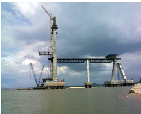
Überbaumontage Rückhaltebereich P26–P30 (1)
