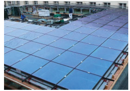
Bild 9. Fertige Dachkonstruktion Fig. 9. Complete roof construction
