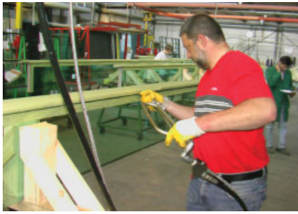
Bild 7. Einspitzen des Silikons zwischen Glasträger und Edelstahlprofil Fig. 7. Injection of the silicon between the glass beam and the profile of high-grade steel
