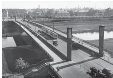
Stahlbrücke von 1926; Original
