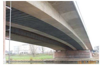
Untersicht mit Gitterrost
