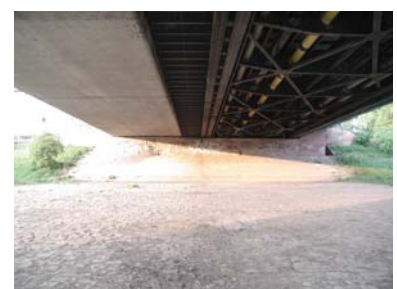
Untersicht vor dem Umbau
