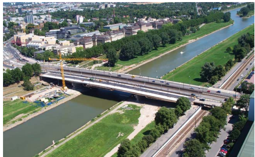
Neue Brücke in Seitenlage
