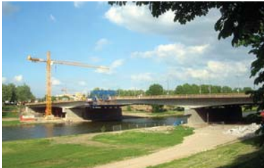
Traggerüst und Freivorbau
