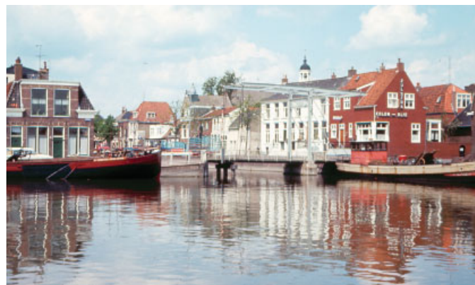
Bild 6. Zugbrücke in Kappeln/Holland Fig. 6. Drawbridge at Kappeln/Netherlands
