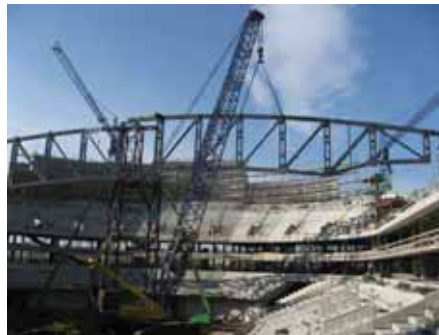
Montage des südlichen Hauptträgers © Leonhardt, Andrä und Partner
