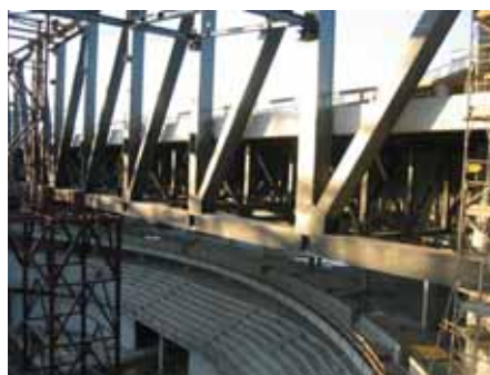
Das nördliche Verbunddach mit dem nördlichen Hauptträger © Leonhardt, André und Partner
