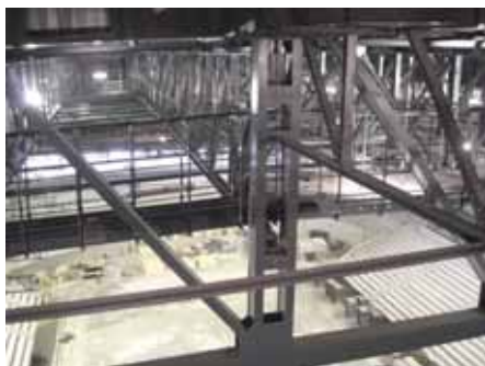
Blick auf den südlichen Hauptträger und das Hauptdach © Leonhardt, Andrä und Partner
