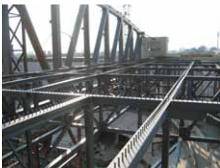
Das Verbunddach im Norden noch ohne Stahlbetonplatte © Leonhardt, André und Partner
