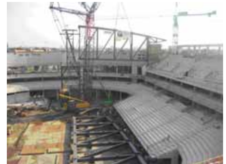
Montage des nördlichen Hauptträgers © Leonhardt, Andrä und Partner
