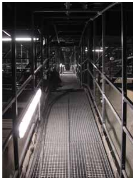
Die Catwalks folgen dem gekrümmten Dachverlauf © Leonhardt, André und Partner
