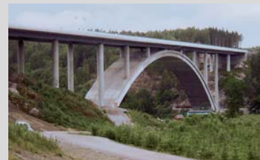
Brücke über den Örekilsälven | Schweden
