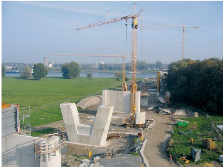
Pfeiler im linksrheinischen Vorlandbereich © Leonhardt, Andrä und Partner
