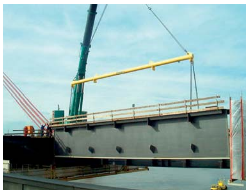
Einhub von Bauteil 3 des Schusses 5 © Leonhardt, Andrä und Partner
