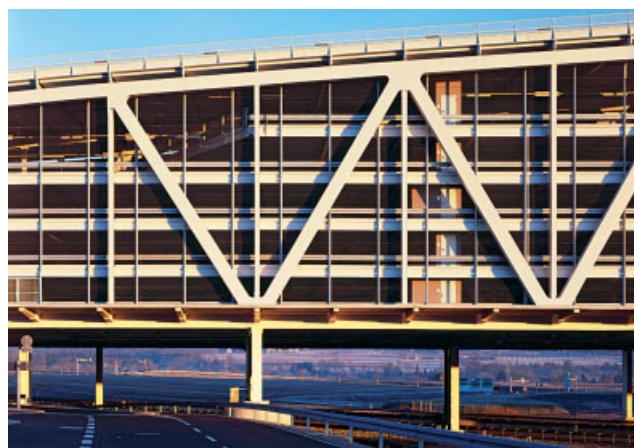
Alle Verbindungen biegesteif – keine Lager
