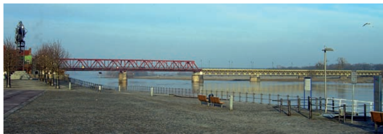
3 Bestehendes Bauwerk © Leonhardt, Andrä und Partner
