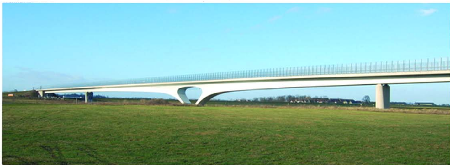
Das Auge von Mühlberg: Mit einer sehr flachen Balkenbrücke konnte der Eingriff in die Elbauen gering gehalten werden.
