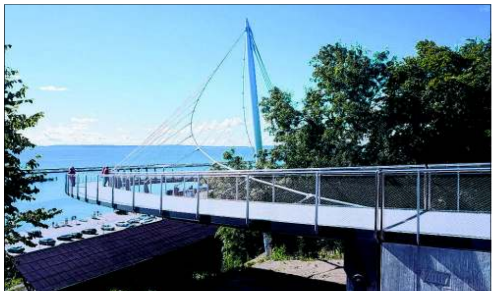
Das Projekt: Eigentlich handelt es sich bei der Fußgängerbrücke im Stadthafen Sassnitz auf der Insel Rügen um eine zweigeteilte Konstruktion, eine 124 Meter lange Rampenbrücke als Verbundkonstruktion und eine 119 Meter weit gespannte Seilbrücke. Bei einem konstanten Gefälle von nur sechs Grad werden 22 Meter Höhenunterschied überwunden. Die Preisträger: Mike Schlaich (li.) und Andreas Keil (Schlaich, Bergemann und Partner)
