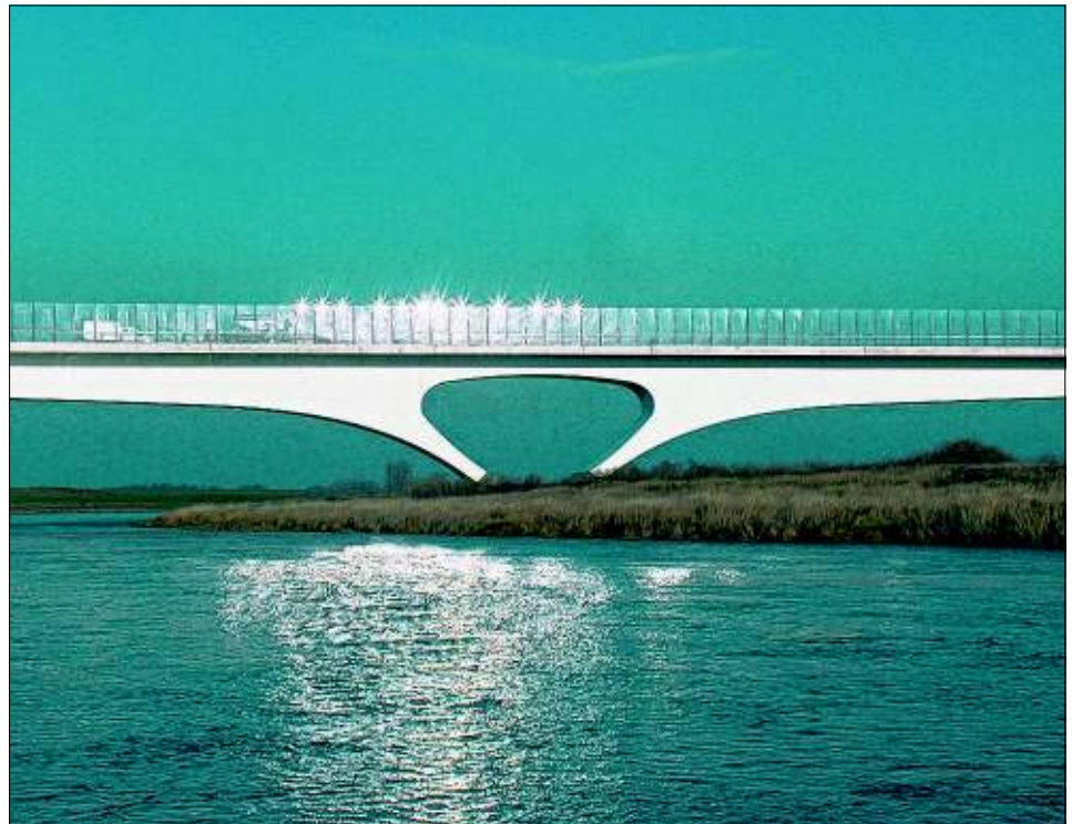
Das Projekt: Zu überbrücken galt es die Elbe bei Mühlberg/Brandenburg in für die Flussauen verträglicher Weise. Die wegen ihrer charakteristischen Mittelstütze inzwischen als das „Auge von Mühlberg“ bezeichnete Konstruktion aus Stahl und Beton überspannt 700 Meter. Der Preisträger: Wolfgang Eilzer (Leonhardt, Andrä und Partner)
